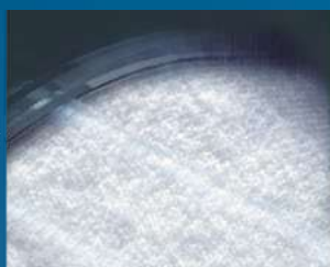
Обмерзание теплообменника
